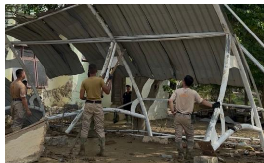
Gambar 8. Proses purifikasi bagian dalam mushola BPKD (kiri) dan Mitigasi bahaya fisik melalui pembongkaran struktur kanopi parkir yang runtuh (kanan).
