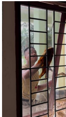
Gambar 6. Pembersihan panel kaca untuk pemulihan ruang kerja kondusif.
