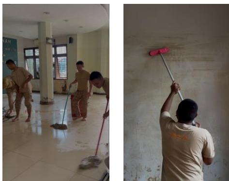
Gambar 5. Sanitasi interior kantor pascapenyemprotan (kiri) dan Restorasi kebersihan dinding dari residu lumpur (kanan).
