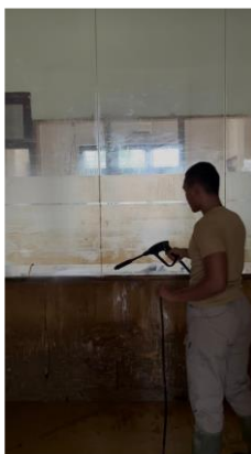
Gambar 4. Eksekusi pembersihan dengan metode penyemprotan bertekanan tinggi ( Water Jet ).
